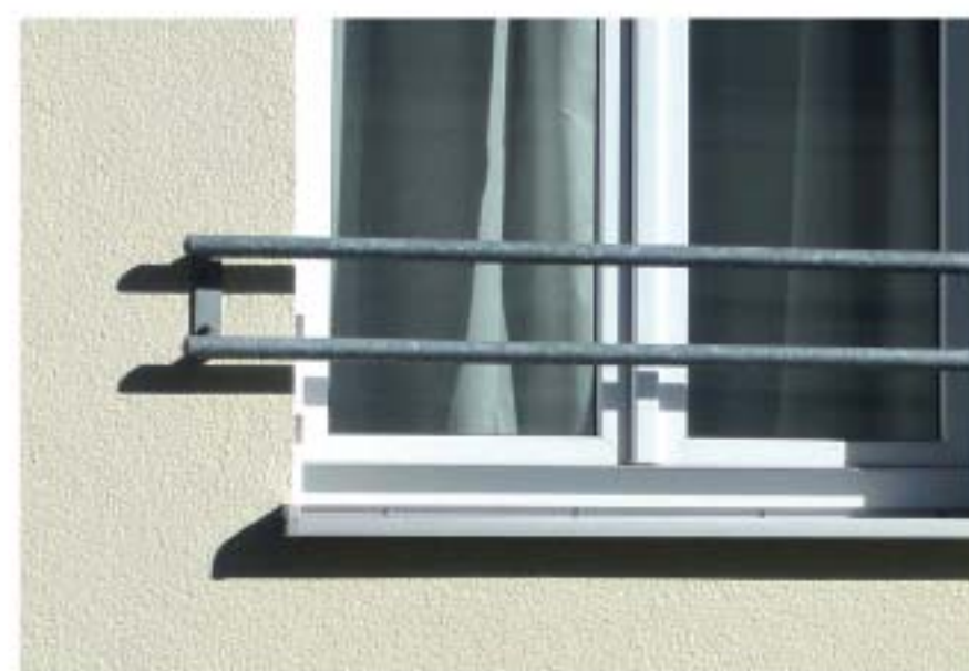
Закрепване на предпазна конструкция
